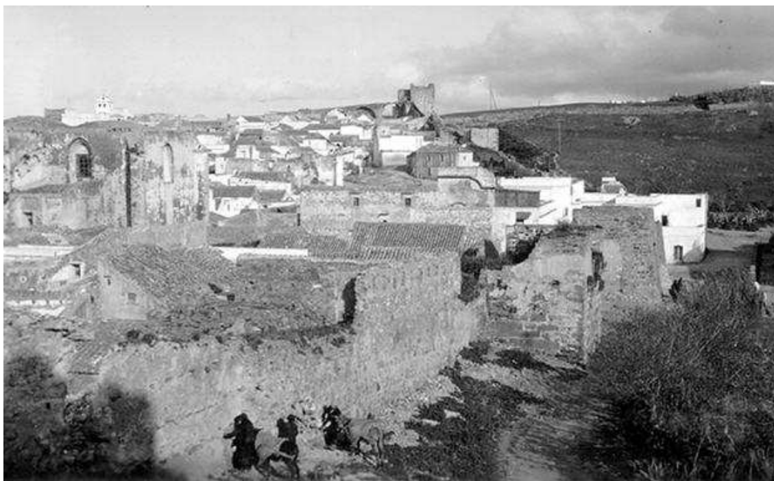
Imagen nº 5.- Zona Este amurallada que sufrió el asedio de 1811 y trasera de la Iglesia de San Mateo. IDEM
