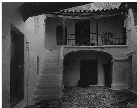
Imagen nº 9 y 10.- Patios de vecinos que hasta la década de 1970 presentaban zonas comunes, con malas instalaciones (baños y cocinas comunes) y hacinamiento. Fotografías de Otto Wunderlich. Archivo General de la Administración.
